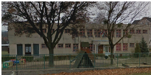
5. ábra Zöldikék óvoda felújítás előtt (forrás: Google street view)
