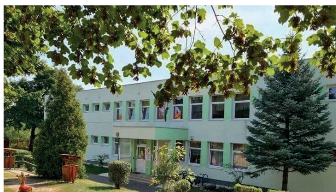
4. ábra A Zöldikék óvoda felújítás után (forrás: https://ajkaovoda.hu/zoldikek-ovoda/fotogaleria/ )
