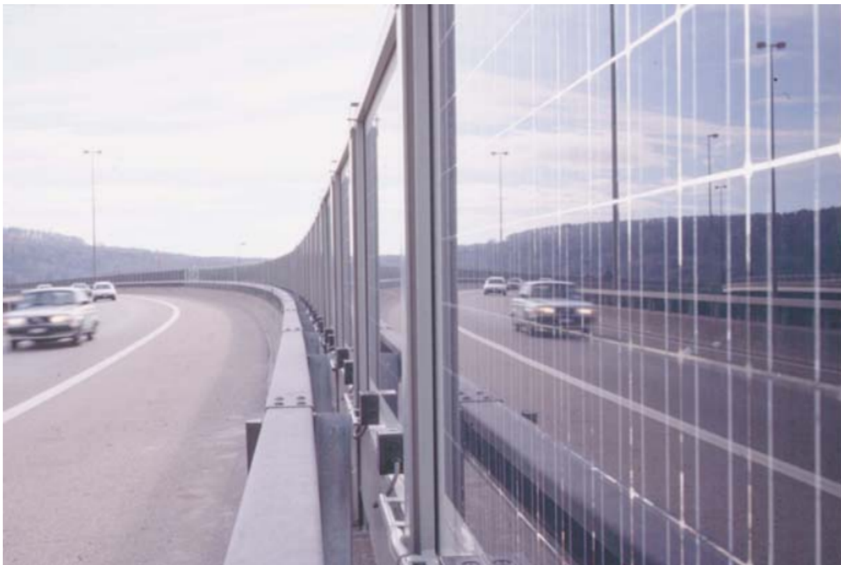
22. ábra: 1997-ben telepített, zajvédelmi funkcióval rendelkező, kétoldalas napelemrendszer Zürich térségében 40
