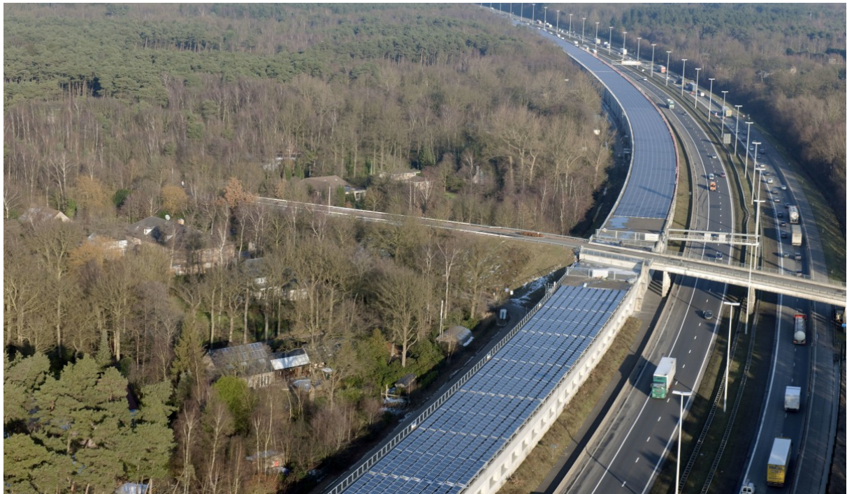
20. ábra: A 2011-ben Antwerpen közelében átadott 3,9 MW teljesítményű napelemes rendszer 3,6 km-es vasúti szakaszt elburkolva termel villamos energiát 36
