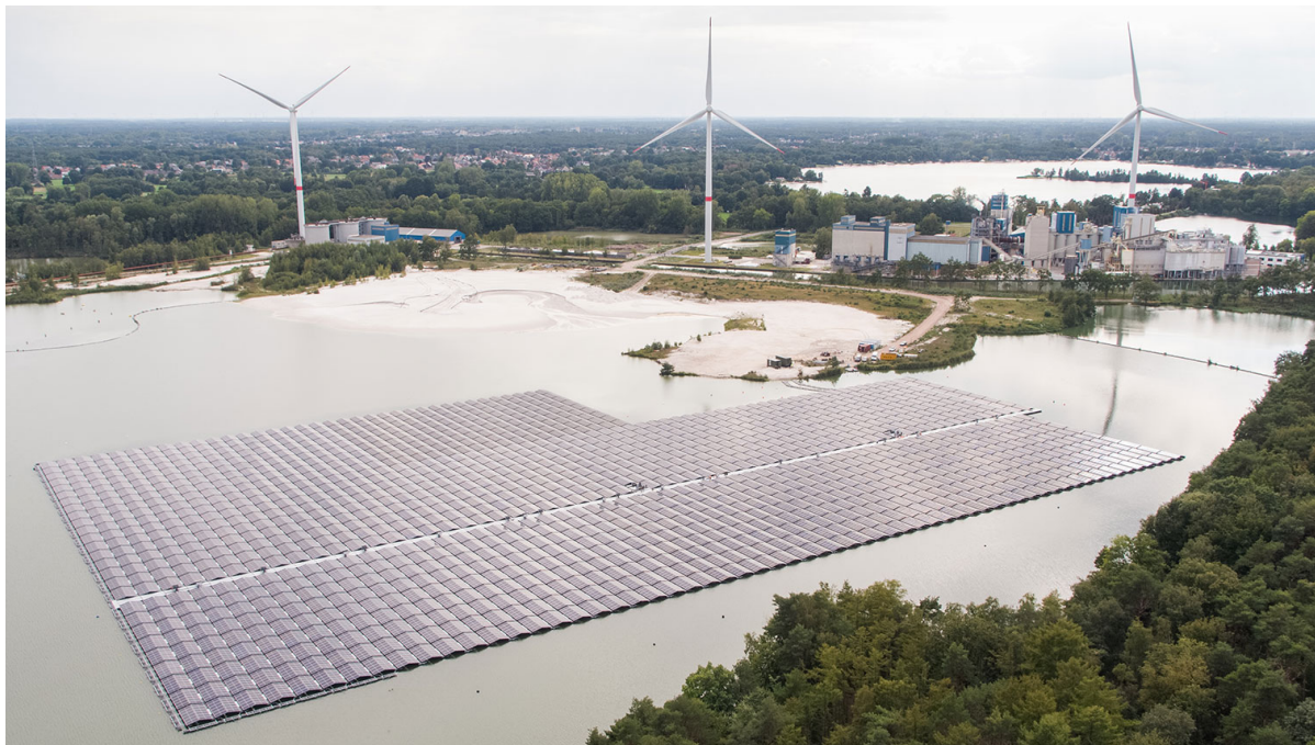
27. ábra: Homokbánya-tó vízfelszínén kialakított, 4,4 hektár területű, csaknem 7 MW-os, úszó napelemes rendszer Belgiumban, Antwerpen térségében 53
