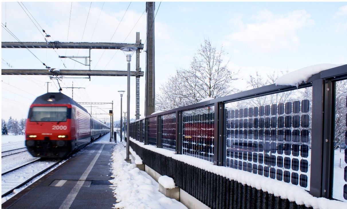
24. ábra: Alacsony építésű kétoldalas napelemrendszer zaj elleni védelemre 42
