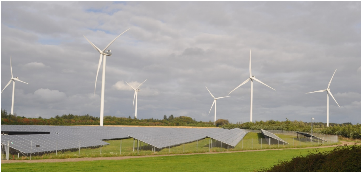
39. ábra: Dánia legnagyobb szárazföldi szélfarmját (22 darab 3,3 MW-os turbina Ringkøbing térségében) egy napelemes rendszerrel kombinálták. A tulajdonosok között a helyi lakosság is felsorakozik, 750 millió dán koronát investálva a projektbe.
