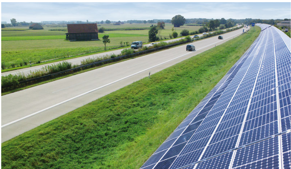
21. ábra: 500 kW teljesítményű zajvédő fal a bajorországi Freising térségében 37
