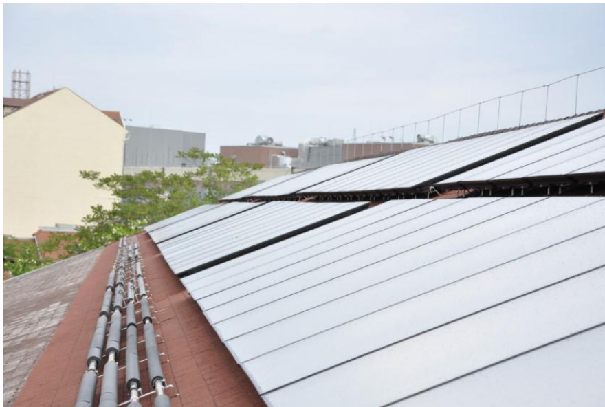
Napkollektoros rendszer a Kispesti Uszodán ( kispestkft.kispest.hu )
