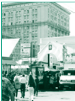
A Minatom épülete Moszkvában
