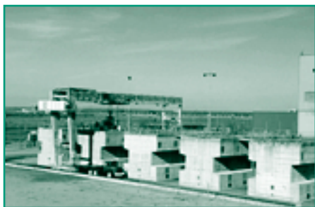
Száraztároló kiégett fűtőelemek számára (Gentyly-2 atomerőmű, Quebec, Kanada)
