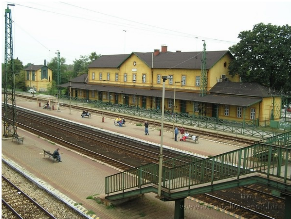
6. ábra A tatai vasútállomás (forrás: 23 )
